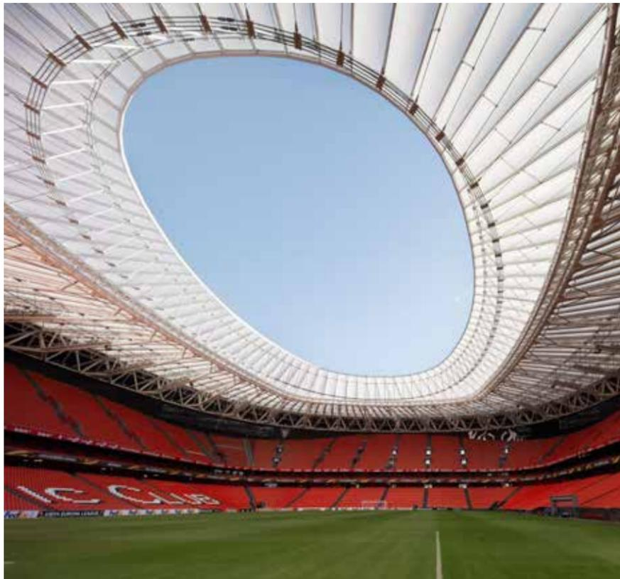
En partant de l'intégration architecturale d'une nouvelle structure qui devait être ajoutée à celle existante, IDOM a conçu et calculé une structure ultra-légère basée sur un système de câble bicouche composé d'un double anneau intérieur de traction et d'un anneau extérieur de compression.
