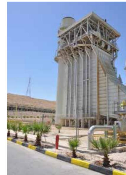
de récupération de chaleur (HRSG) à trois niveaux de pression, une turbine à vapeur de 75 MW, un aérocondensateur (ACC) et tous les systèmes auxiliaires associés nécessaires pour réaliser un circuit eau-vapeur fermé.
