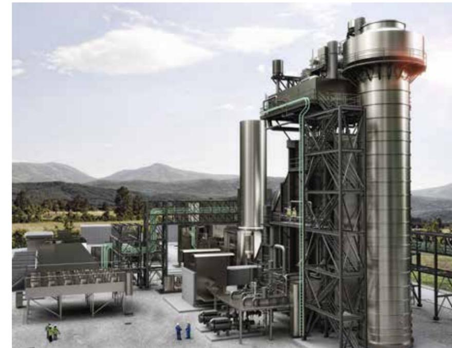
Le rack d'interconnexion constitue un élément différenciateur du projet. La station de cogénération d'Aconcagua alimente la raffinerie en vapeur par un collecteur de 16" de diamètre et pas moins de 2,1 km de long. La complexité de la conception du rack, dont le tracé passe par une raffinerie et des zones fréquentées par le public, est équivalente à celle de la station même.
