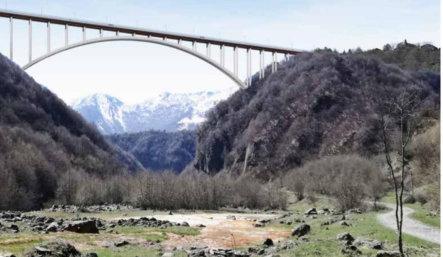
La solución diseñada en la fase de ingeniería de detalle, para el tramo central, Kvesheti-Kobi, reduce la longitud del recorrido de 35 km a 22 km, y el tiempo de viaje de una hora a, aproximadamente, 20 minutos, mejorando sustancialmente las condiciones de seguridad vial durante su explotación. Para conseguirlo, la futura carretera incluirá varios viaductos y túneles, destacando un puente arco de 432 m de longitud total y una luz de 285 m sobre el valle de Khada.
