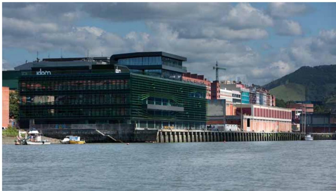
Durante el proceso de proyecto desarrollamos varios y múltiples diseños, decantándonos finalmente por una solución horizontal, la de óptimo equilibrio entre la estética, coste y mantenimiento: perfil extruido de aluminio soportado en perfiles HEA de acero con tornillos de acero inoxidable AISI 316.
