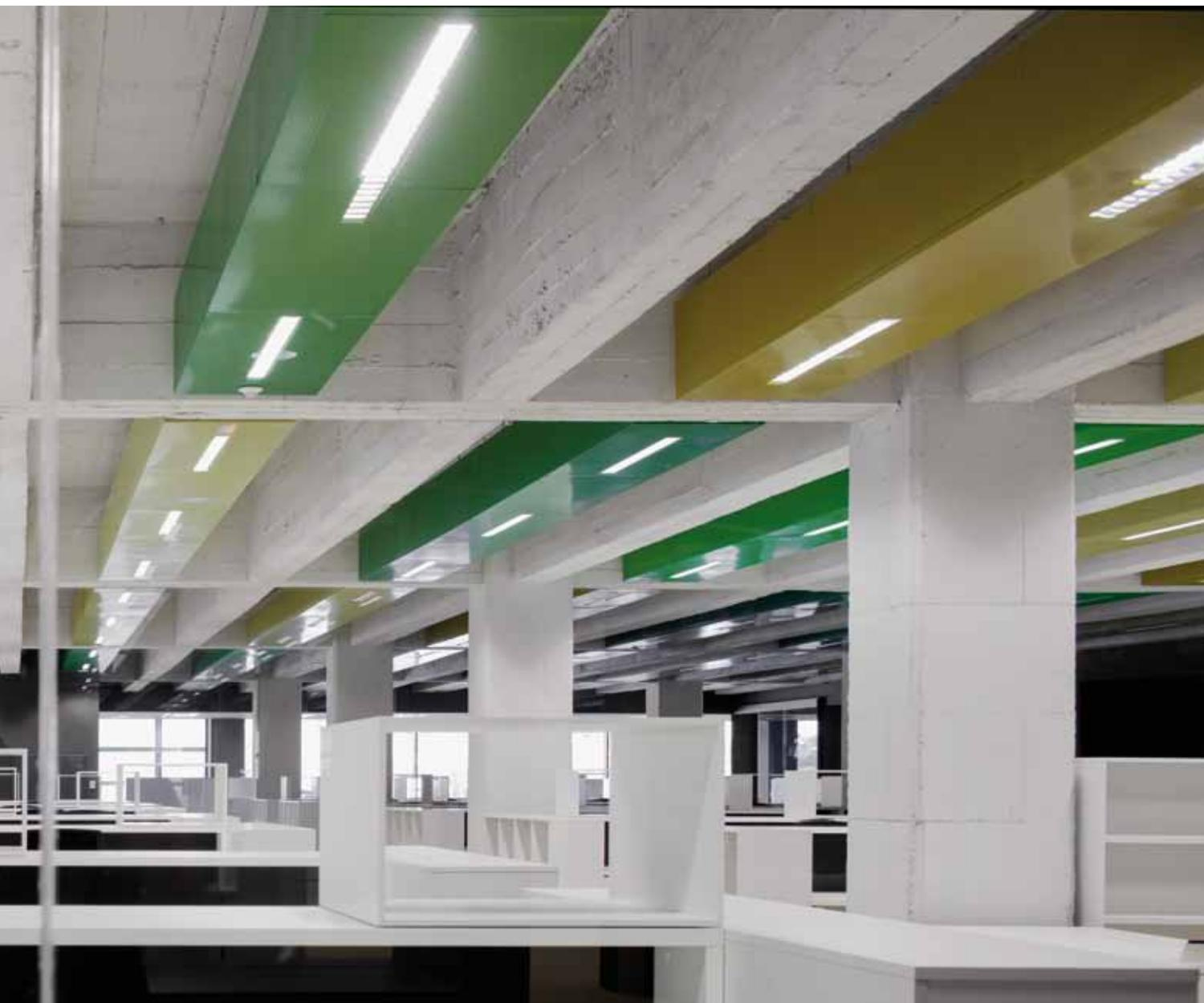
El sistema de difusión de la ventilación es por desplazamiento: el aire sale por el suelo, a muy baja velocidad y a medida que se calienta llega al techo donde, en contacto con las baterías, es tratado para descender posteriormente por convección natural. Una instalación sin corrientes de aire, confortable y silenciosa.
