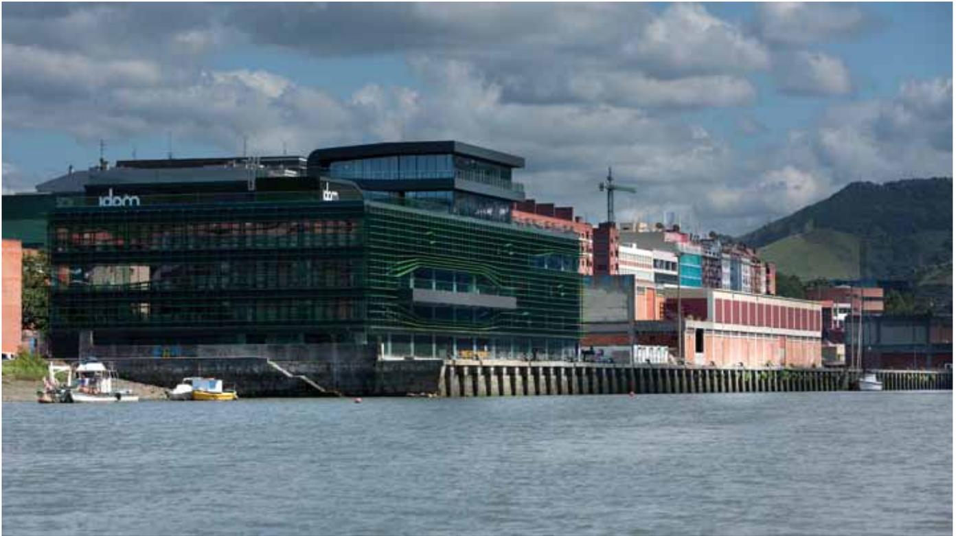
Durante el proceso de proyecto desarrollamos varios y múltiples diseños, decantándonos finalmente por una solución horizontal, la de óptimo equilibrio entre la estética, coste y mantenimiento: perfil extruido de aluminio soportado en perfiles HEA de acero con tornillos de acero inoxidable AISI 316.
