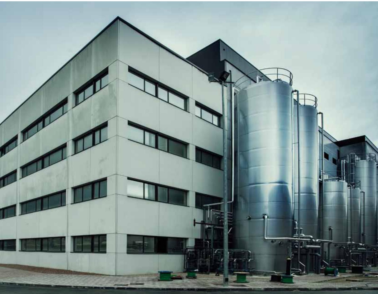
La planta dispone, entre otras instalaciones, de un grupo con una potencia eléctrica instalada de 14 MVA, una capacidad de producción frigorífica de 11 MW y una instalación de vapor con capacidad para 12 toneladas/hora.
