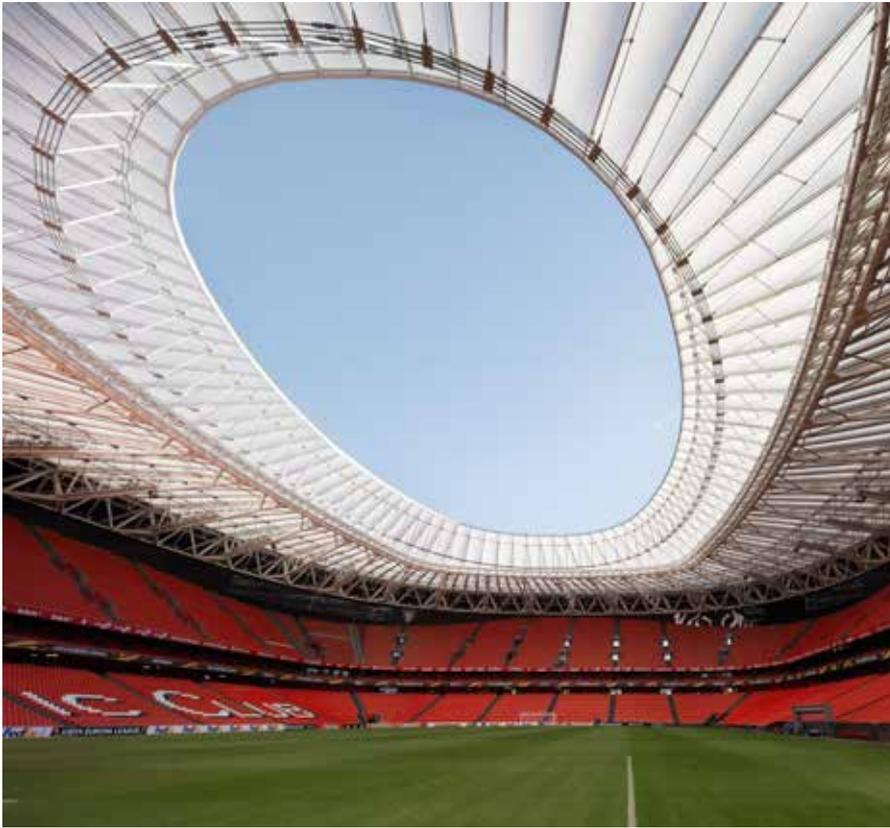
Partiendo de la integración arquitectónica de una nueva estructura que debía añadirse a la existente, IDOM ha diseñado y calculado una estructura superligera basada en un sistema de cables bi-capa compuesto por un doble anillo interior de tracción y un anillo exterior de compresión.
