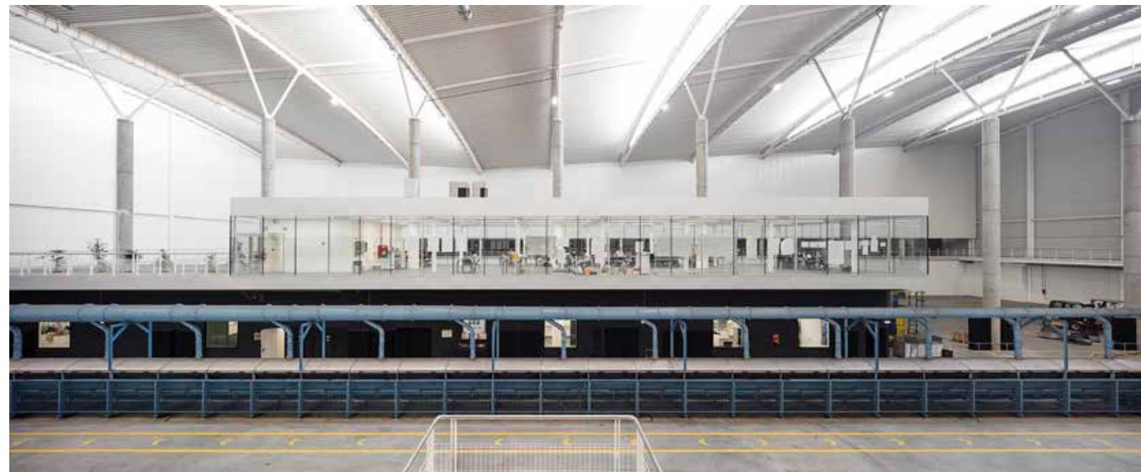
Gli ampi e luminosi spazi interni
