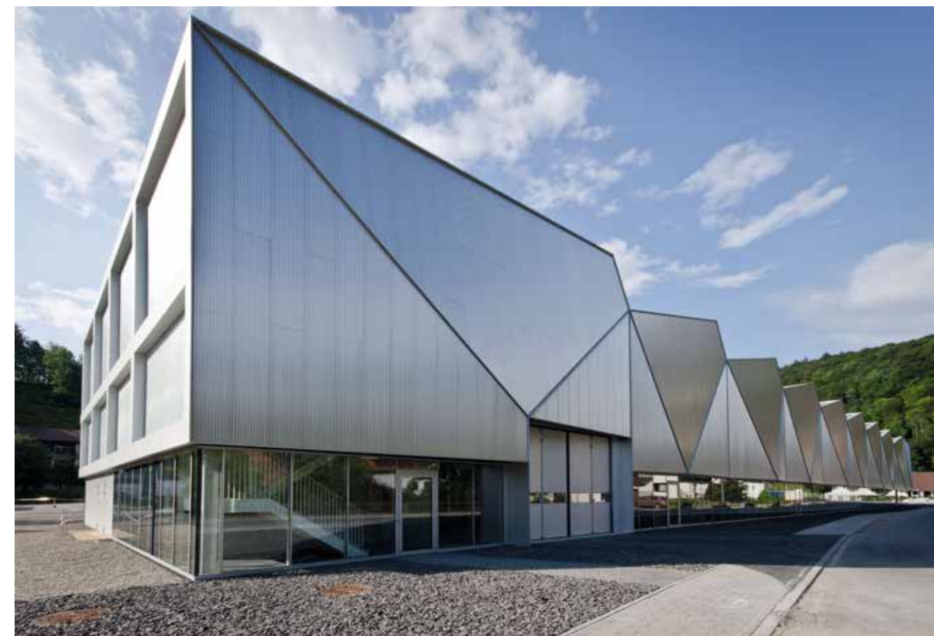
La copertura a shed realizzata con pannelli in acciaio
