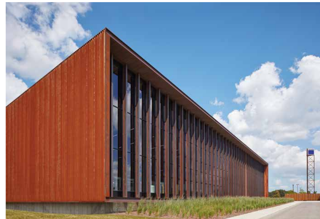
L'esterno rivestito da pannelli di acciaio Corten
