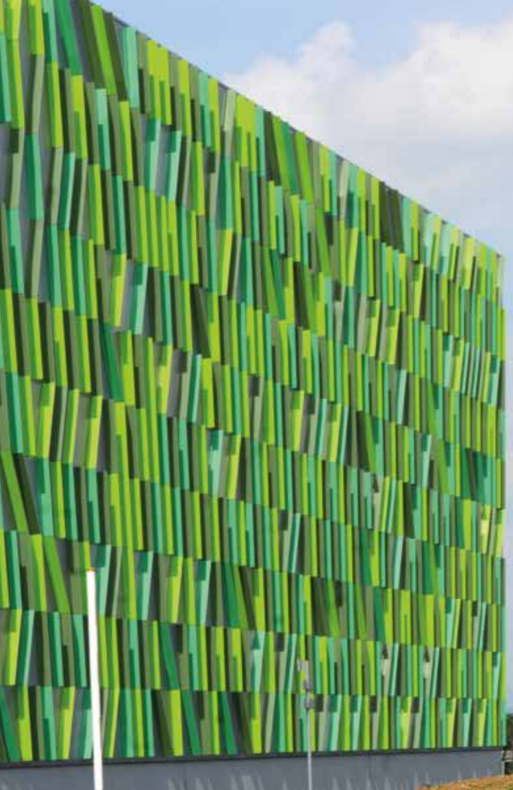
Il rivestimento continuo in pannelli d'acciaio
