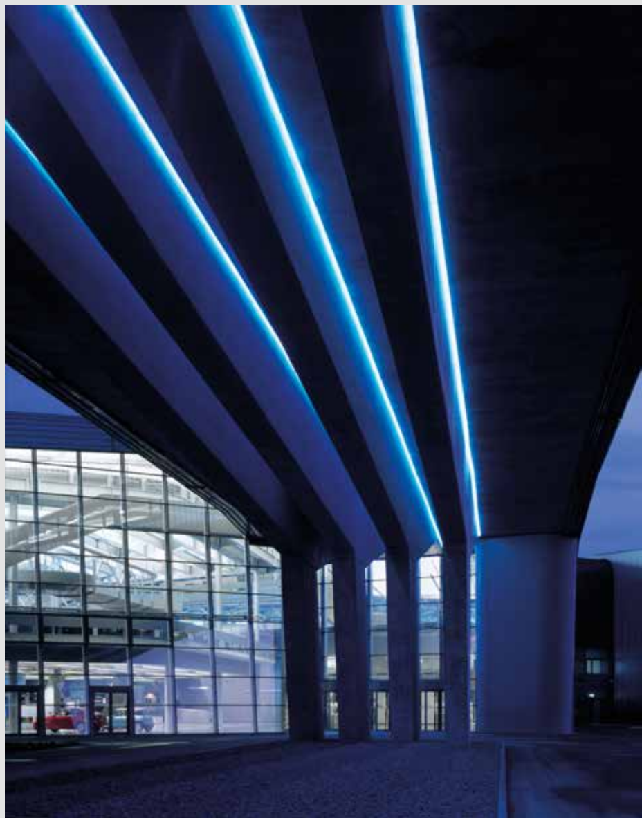
Le vetrate e la struttura in calcestruzzo armato lasciata a vista
