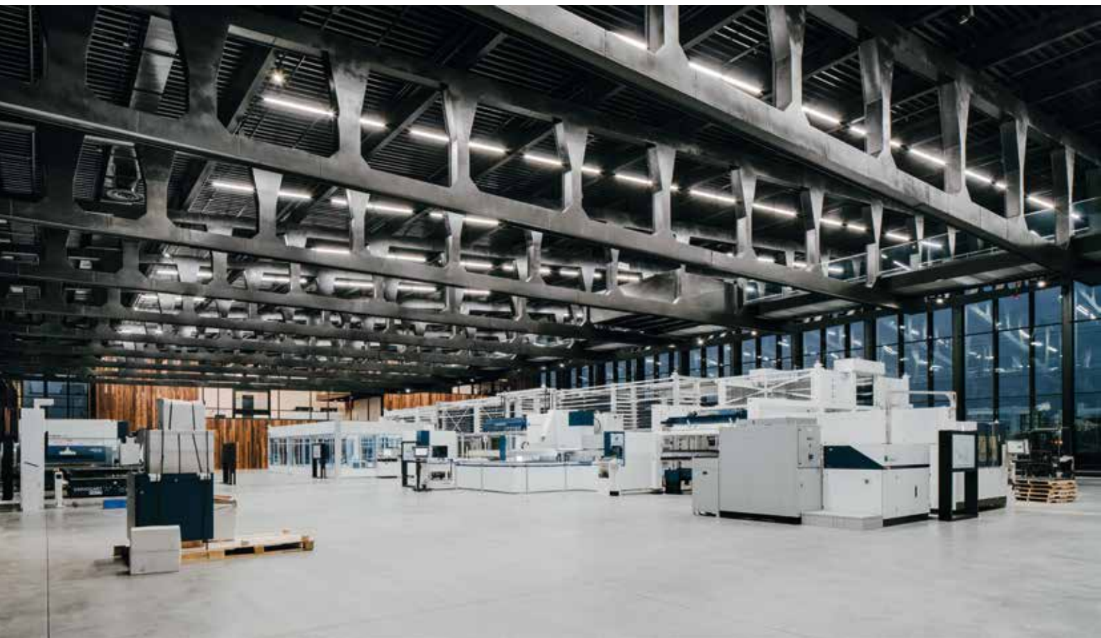
Il sistema delle travature interne
