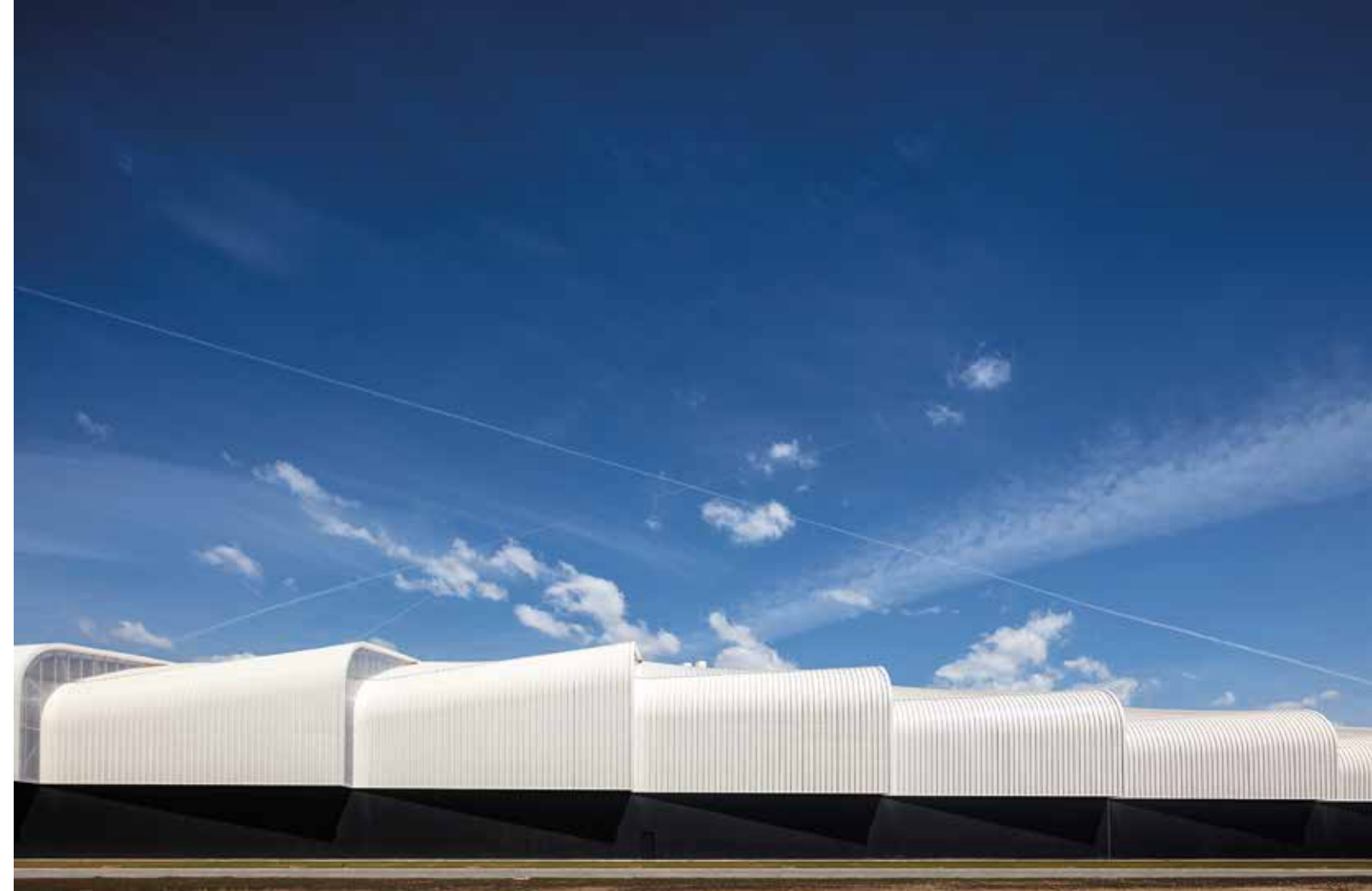
La copertura realizzata con piastre in lamiera autoportanti
