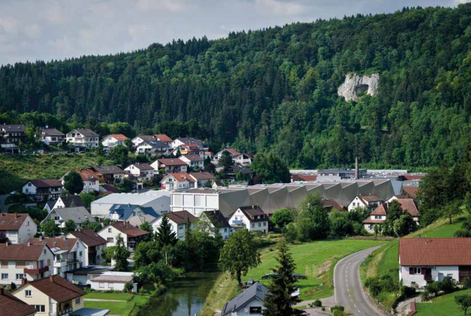
Il contrasto dello stabilimento inserito nel contesto del villaggio
