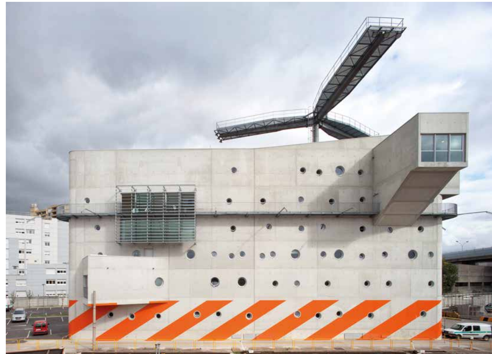
Il volume brutalista della struttura
