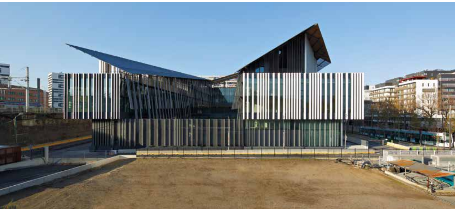
I pannelli in zinco del prospetto esterno
