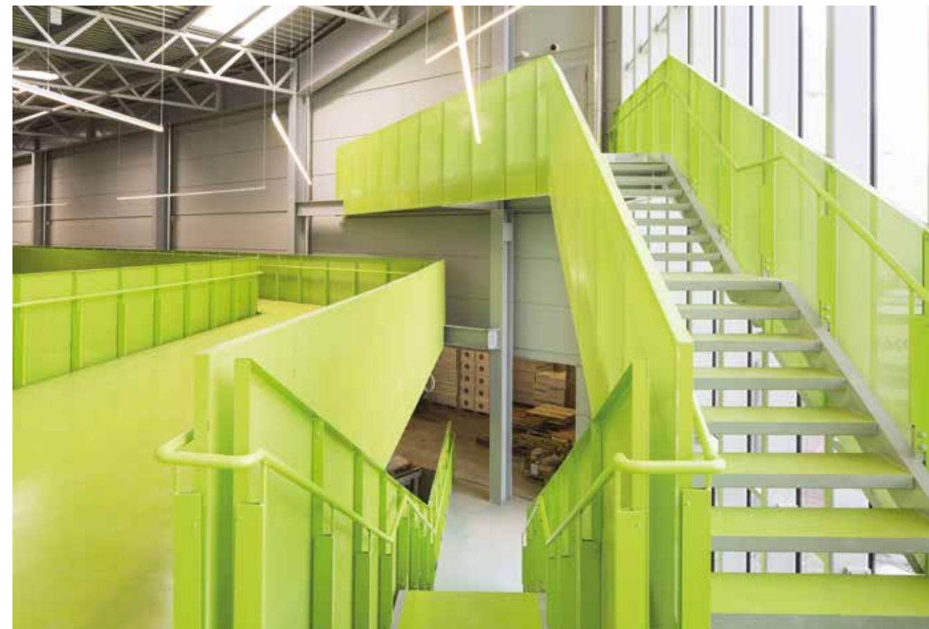
Lo spazio interno del magazzino automatico
