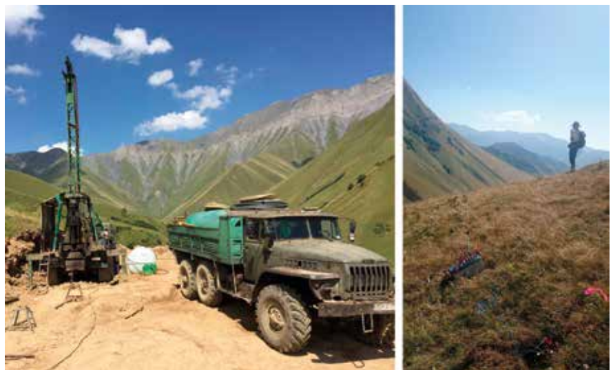
Fig. 4_ Trabajos de campo en el Túnel de Gudauri. Izquierda: perforación de sondeo en emboquille Sur (Tskere). Derecha: trabajos de adquisición de tomografía eléctrica profunda
