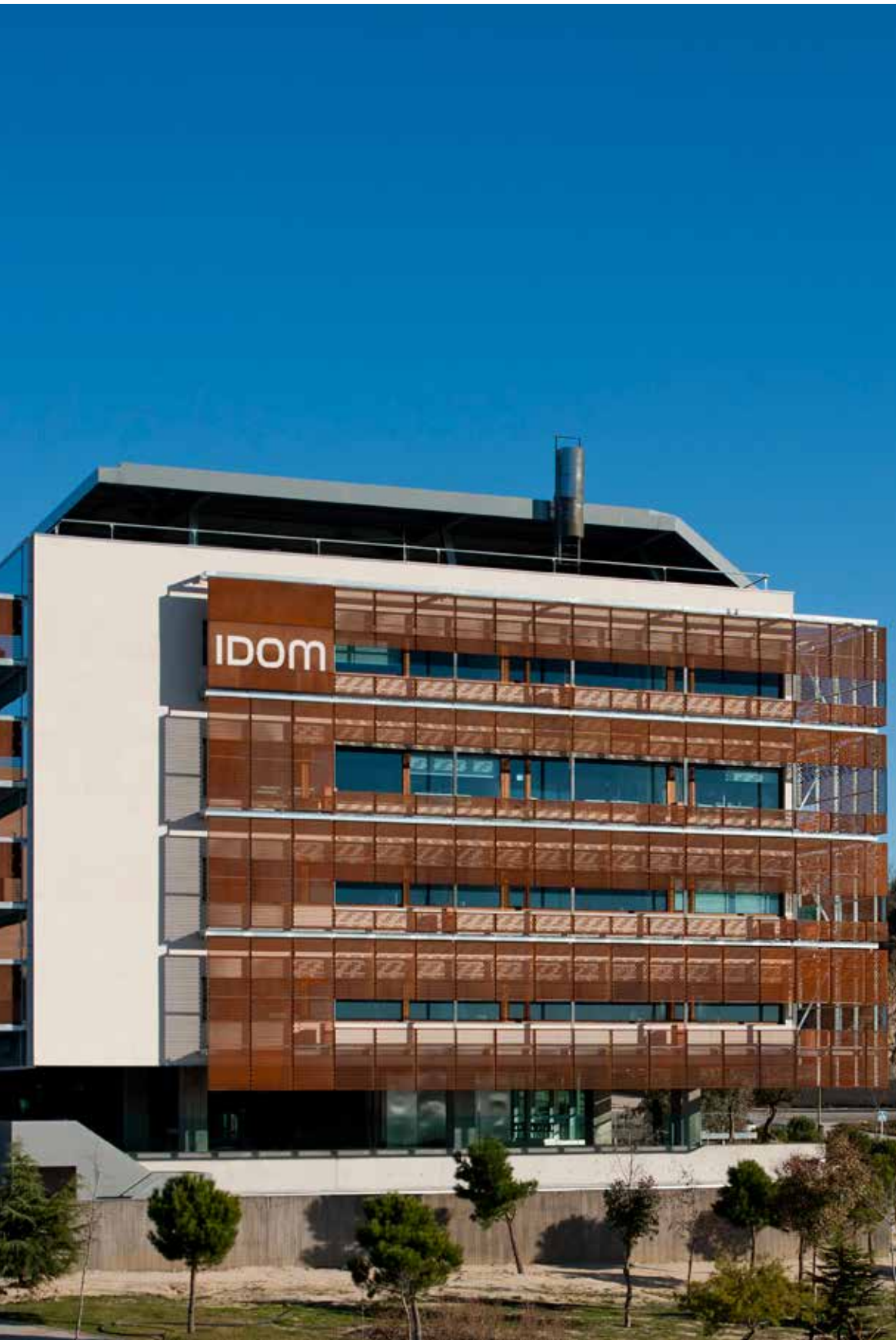
Sede de IDOM Madrid. La sede de IDOM en Madrid resuelve el reto de conseguir, en un edificio de oficinas, unos resultados excepcionales en confort y consumo energético. El edificio alcanzó la Certificación de Edificación Sostenible LEED Gold.
