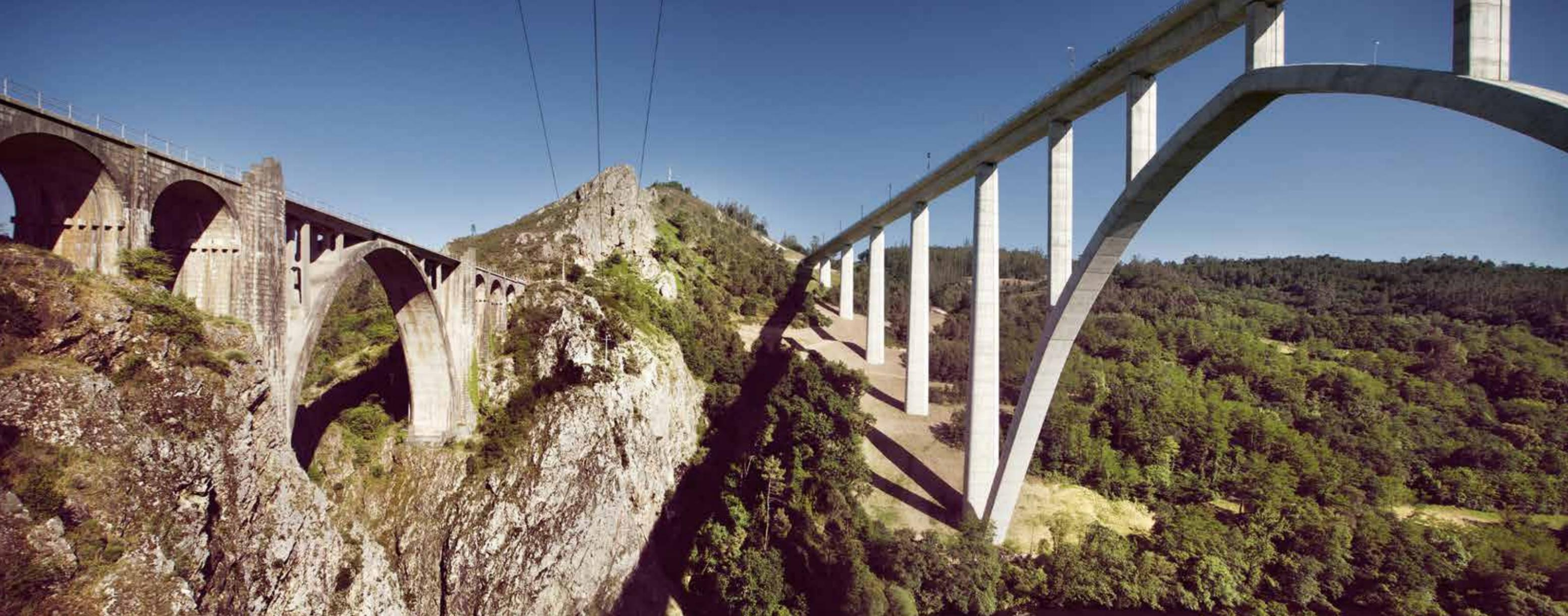
Se trata de un proyecto de plataforma con una longitud total de 43,7 km, que incluye una longitud total de túneles (éstos realizados mediante el Nuevo Método Austriaco) y viaductos de 13,2 y 9,7 km respectivamente. Está diseñado bajo parámetros que permiten desarrollar una velocidad de 350 km/h.
