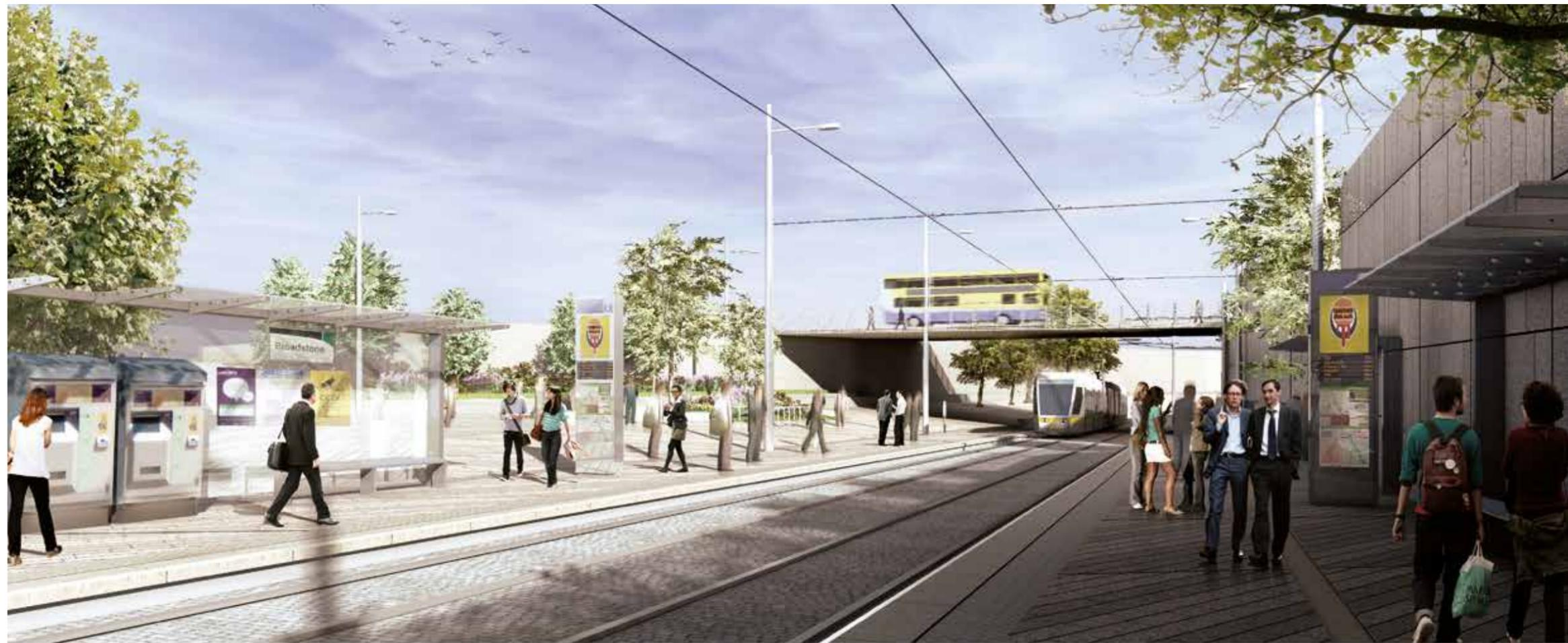
Idom ha preparado propuestas de diseño para el nuevo LUAS Cross-city, una ampliación de la línea verde del tranvía de Dublín. El diseño consiste en un doble juego de vías, con una longitud de 5,6 km y un ancho de vía de 1.435 mm, que discurre desde la parada de St. Stephen's Green, en el centro de la ciudad, hasta Broadstone, frente a las cocheras de autobuses. Desde Broadstone hasta el final de la línea, las vías discurrirán a lo largo de la vieja trinchera viaria.
