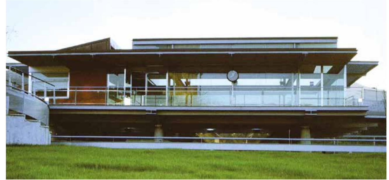
Obra realizada dentro del Plan de Mejoras previsto por el Departamento de Transportes y Obras Públicas del Gobierno Vasco para los accesos a Bilbao. La nueva estación se construye sobre el andén que se proyecta central, permitiendo así el acceso directo y rápido a la zona de vías. En el nivel superior se ubican los diferentes usos previstos: expedición de billetes, quiosco, vestuario y vestíbulo. La propia estación cubre la zona de andenes permitiendo el abrigo de la lluvia.
