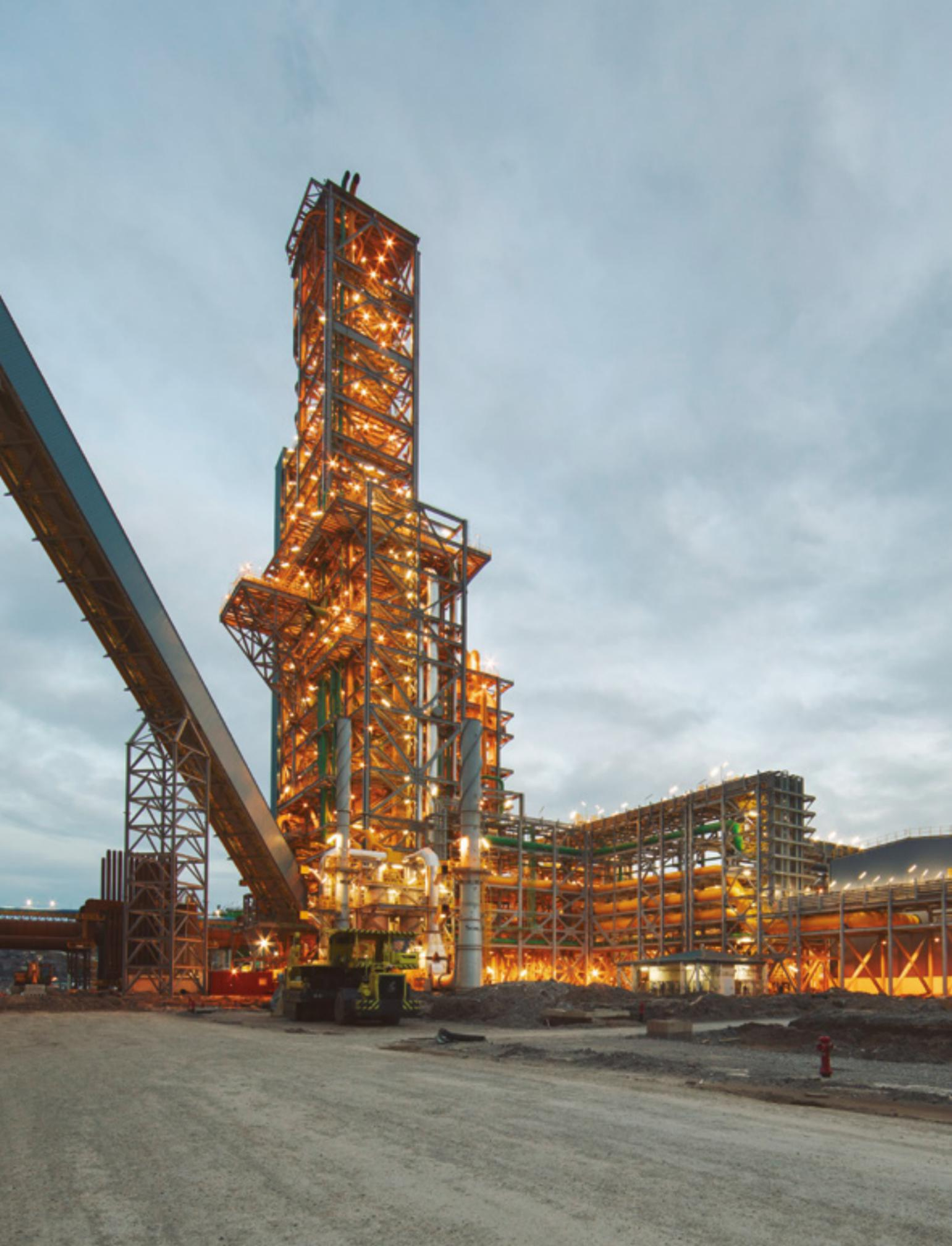
Producción de acero verde usando la tecnología de hierro prereducido con hidrógeno: una apuesta por la descarbonización del acero
