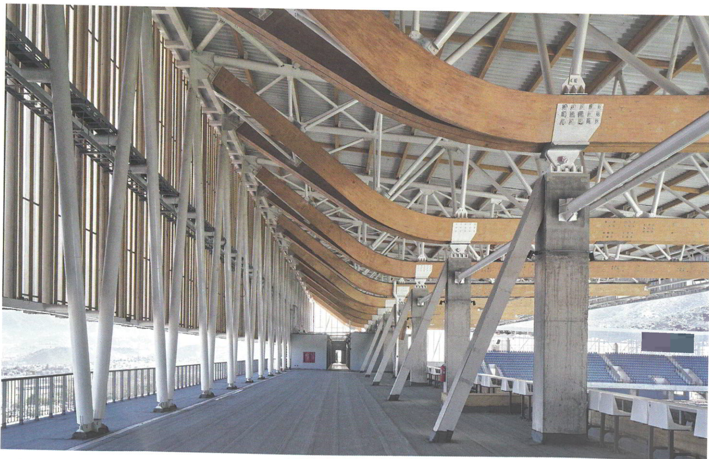
Cubierta desde el interior con las vigas de madera
