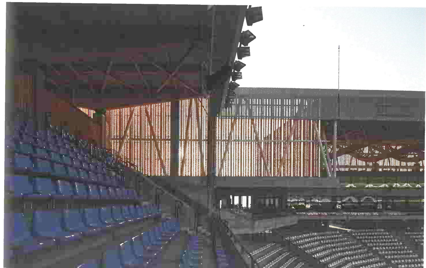
Vista de las vigas y lamas verticales de madera
